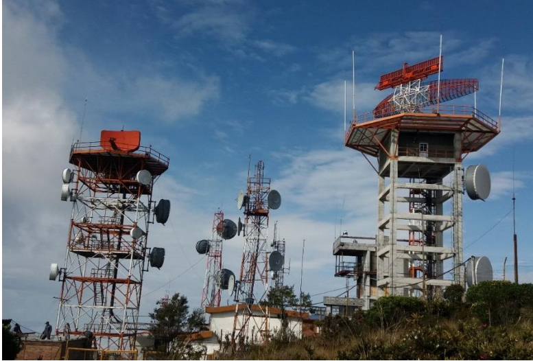
Ilustración 89 Estación Radar El Tablazo
