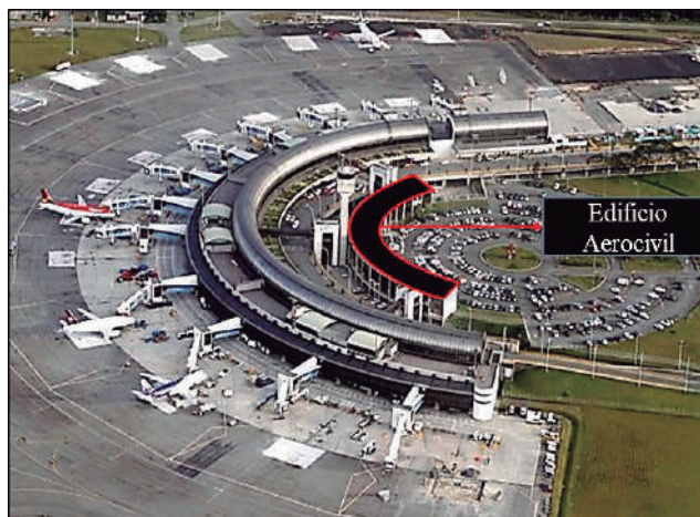
Fig. 3. Edificio Aerocivil. Fuente: elaboración propia
